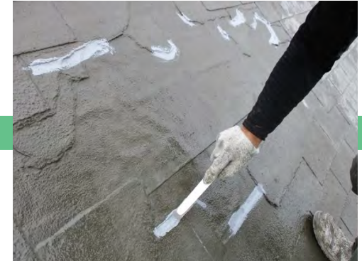
下地調整 (シーリング)
