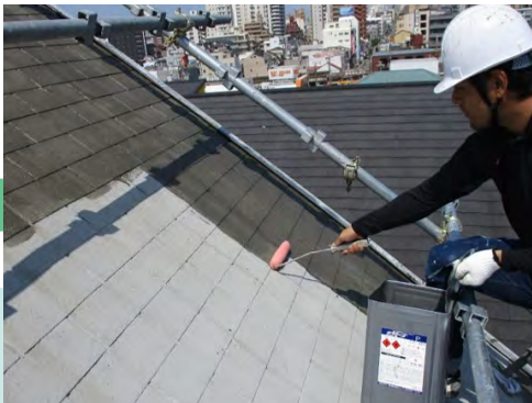
プライマー塗布
