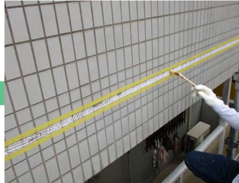
シールプライマー塗布
