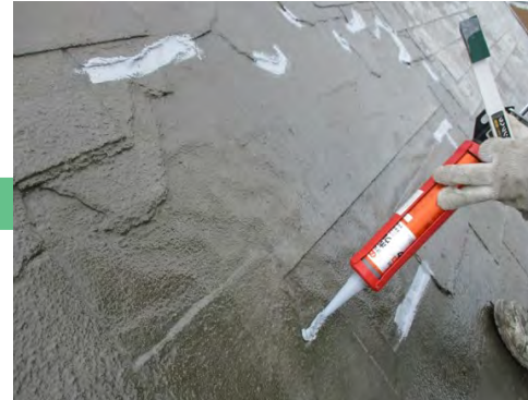
下地調整 (シーリング)
